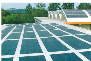
Toiture : Panneaux photovoltaïques intégrés, étanchéité
